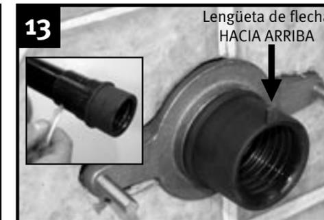
Aplique lubricante a la parte externa del casquillo de caucho y la zona acanalada del interior. Inserte el tubo y el casquillo con la lengüeta de flecha en la parte superior. Lubrique la tubería de descarga del orinal.
