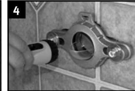
Utilice una linterna de mano para verificar el nivel/inclinación. No debe quedar agua en el disco de inspección o niple. Retire la brida después de la inspección.
