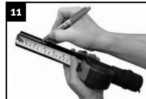
Busque la profundidad del niple de drenaje en la tabla de corte (a la izquierda) y marque la longitud de corte especificada en el tubo de inserción en la ranura de 1/4" más cercana.
