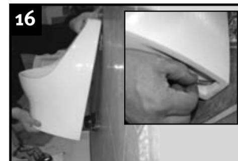
Cuelgue la taza del orinal, insertando la tubería de descarga en el casquillo, instale luego los tornillos de anclaje con las arandelas. Apriete los pernos de la brida y la abrazadera.
