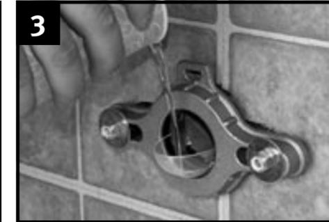
Limpie la cara de la brida de la pared e instale la brida de latón con el disco de inspección transparente. Vierta lentamente agua en el drenaje.
