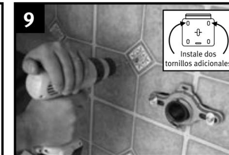
Perfore otros dos orificios para el soporte para colgar, instale los tornillos y apriete. Perfore también orificios para los tornillos de anclaje inferior e inserte las anclas de plástico.
