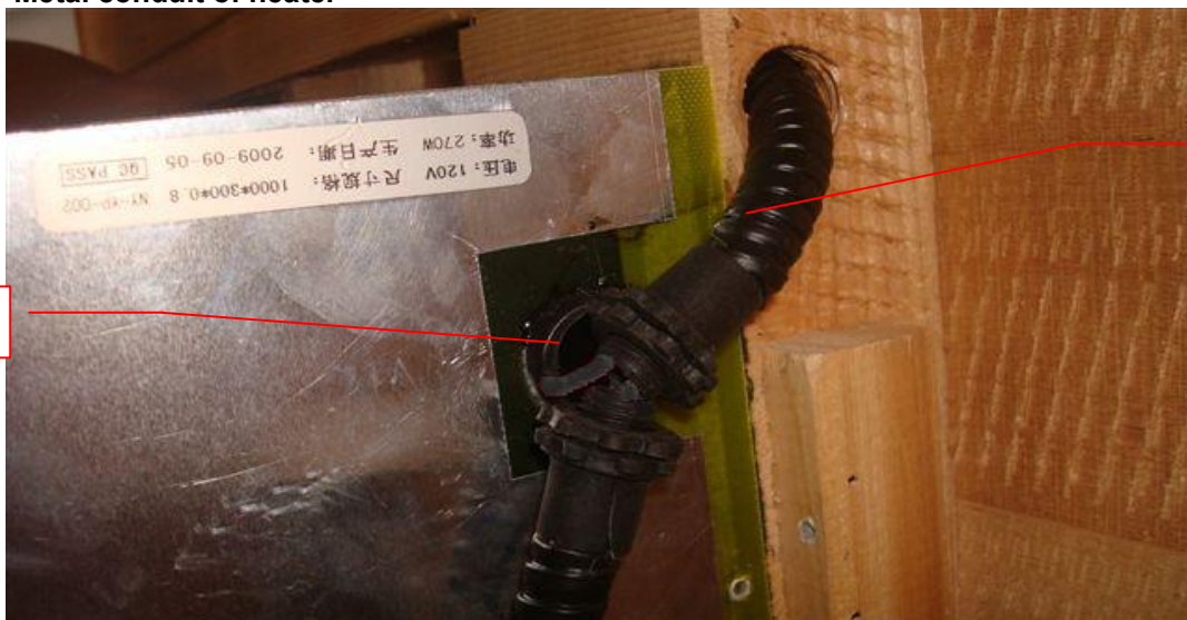
Photo 50 - Metal conduit of heater
